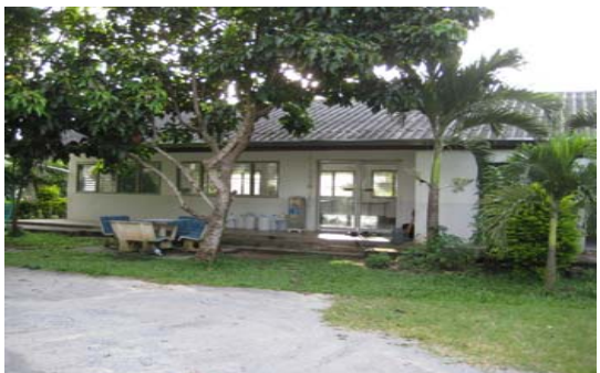
อาคารห้องเตรียมอาหาร
